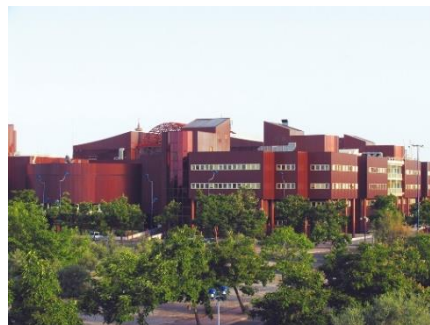
Edificio de la ETSI, sede de URSI 2019.
